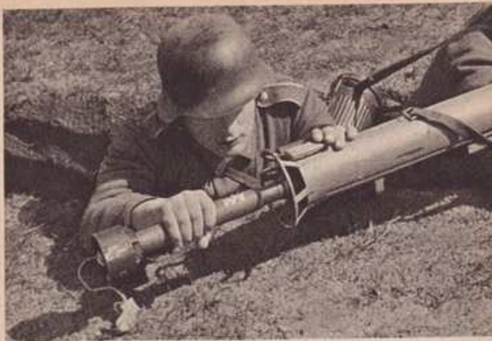
Der Ladeschütze umfaßt nun die Düse im Leitwerk und schiebt die Granate unter leichtem Druck bis zum Anschlagbolzen ins Rohr.
